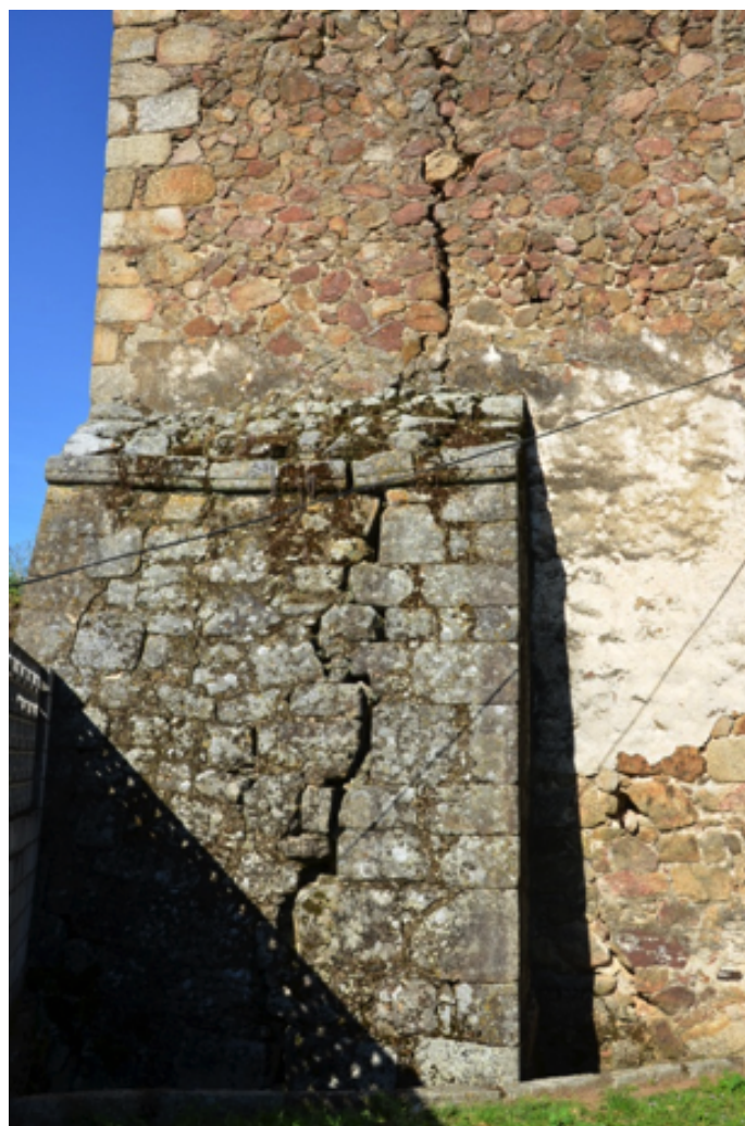
La torre adjunta a la cabecera (muros del oeste y del sur); se hace muy evidente la grieta que también afecta al contrafuerte.
