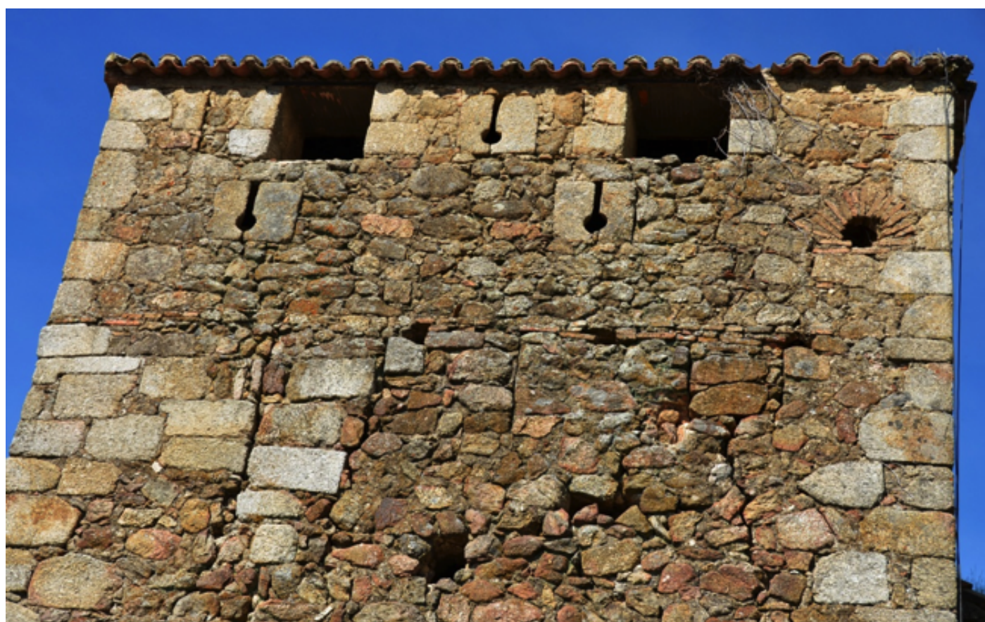
La torre adjunta a la cabecera (muros del oeste y del sur); se hace muy evidente la grieta que también afecta al contrafuerte.
