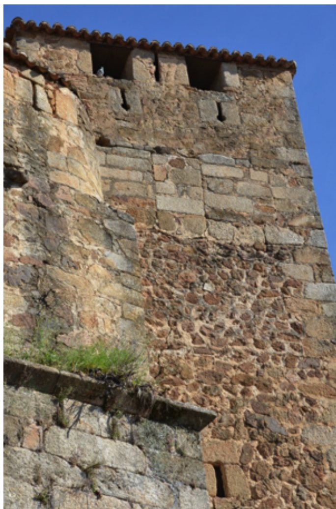
La torre adjunta a la cabecera (muros del oeste y del sur); se hace muy evidente la grieta que también afecta al contrafuerte.
