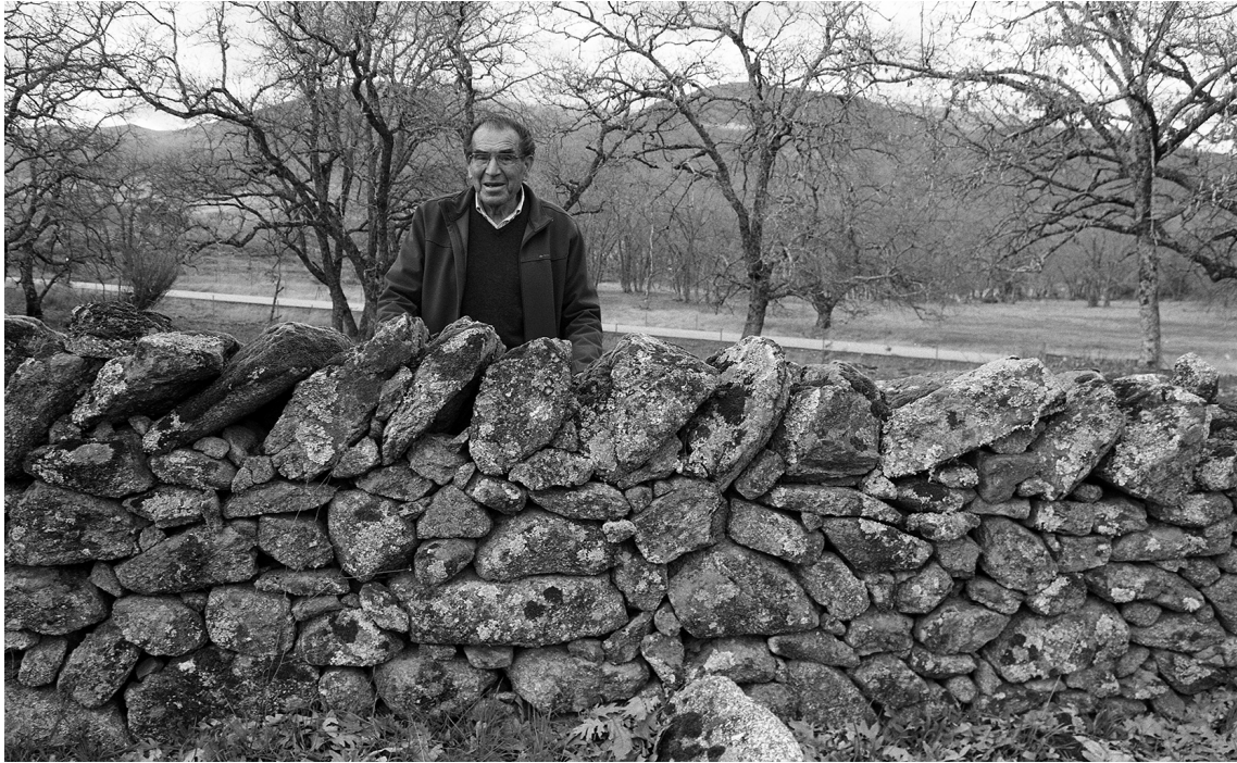
EL LLAVEO CON LOSAS APILADAS EN FILAS VERTICALES. LAS CUACAS.
