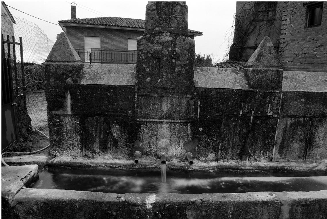
Su longitud es de 3,50 m; su anchura 1,20 m; y la altura del poste central 2,50 m; la altura del pilón es de 35 cm.
